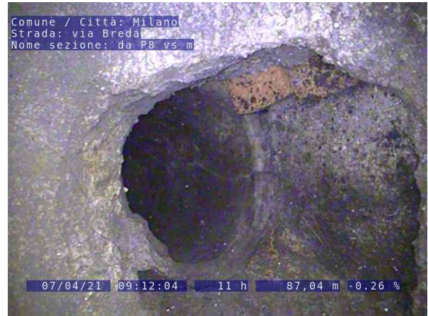
32, 00:13:51, 87.04m Allacciamento, semplice, scalpellato, aperto, diametro 300mm a ore 11
