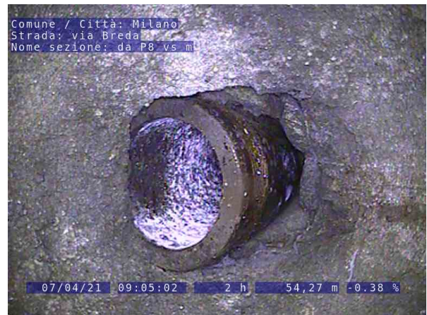
22, 00:08:44, 54.27m Allacciamento, semplice, scalpellato, aperto, diametro 100mm a ore 2
