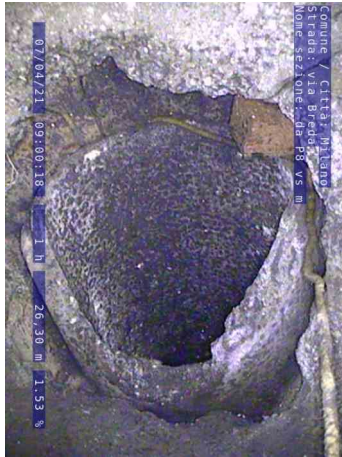
13, 00:05:17, 26.30m Allacciamento, semplice, scalpellato, aperto, diametro 100mm a ore 2
