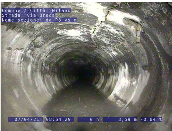
5, 00:01:18, 5.26m Allacciamento, semplice, scalpellato, aperto, diametro 100 mm, a ore 1
