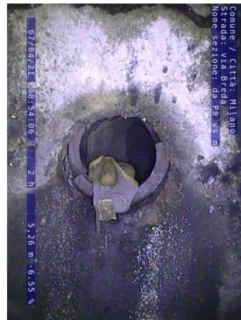
4, 00:01:18, 5.26m Allacciamento, semplice, scalpellato, aperto, diametro 100 mm, a ore 1
