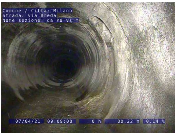
29, 00:12:15, 81.88m Allacciamento, semplice, scalpellato, aperto, diametro 300mm a ore 2
