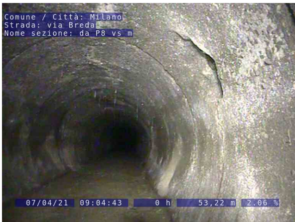
21, 00:08:44, 54.27m Allacciamento, semplice, scalpellato, aperto, diametro 100mm a ore 2
